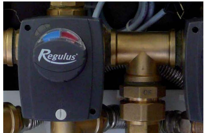
32. Pohon namontovat na levý směšovací ventil.
